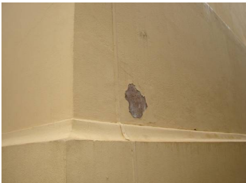
Base da Fachada Principal
