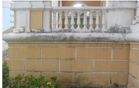
Base pórtico principal
