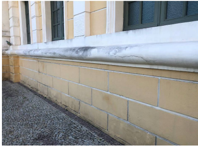
Cimalha inferior da Fachada Direita
