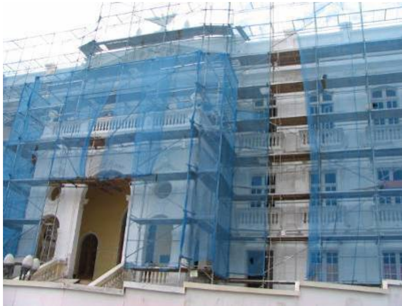
Aplicação de selador acrílico na Fachada Principal
