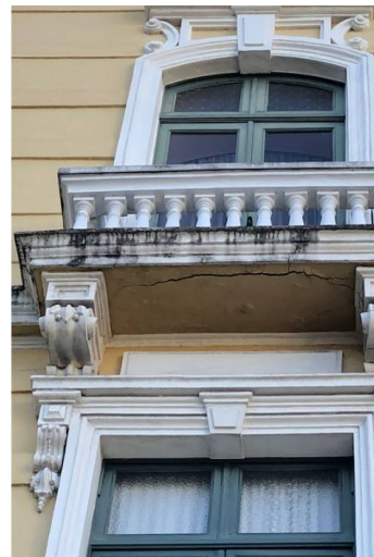
Balcões Fachada Principal
