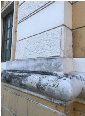
Cimalhas Fachada Principal
