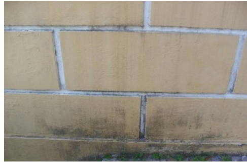
Base do Edifício Fachada Principal
