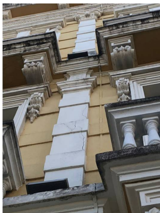
Pilastras da Fachada Principal
