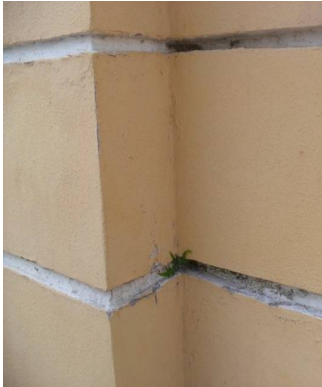
Base da Fachada Principal
