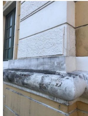
Cimalha inferior da Fachada Principal
