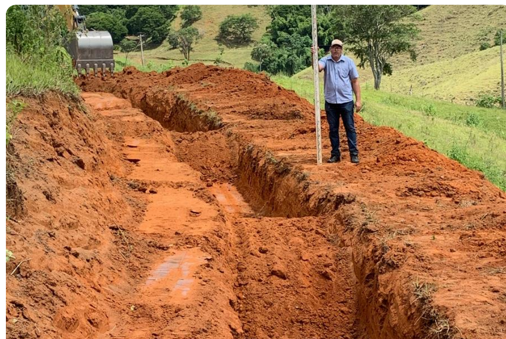
#03 Construção de terraço em nível (cochinho)
