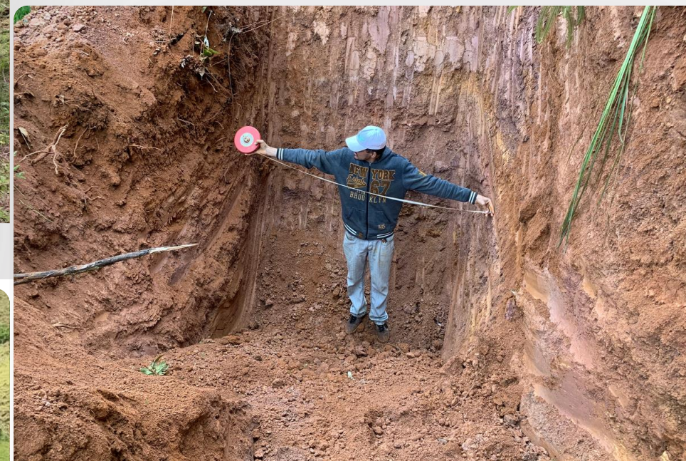
#02 Construção de caixa seca
