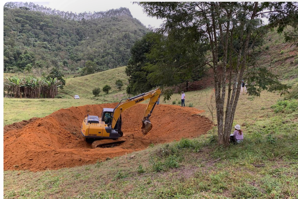
#01 Construção de bacia de infiltração
